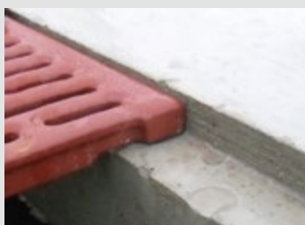
Auflagehöhe auf Beton 20 mm Auflager ca. 25 mm
